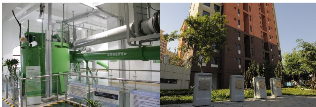
图 21 生态城垃圾气力输送系统中央收集站内及室外投放口场景
