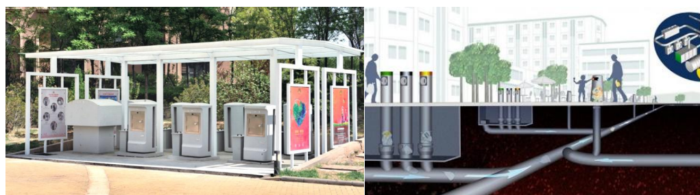
图 5：生态城居住区的气力输送系统
