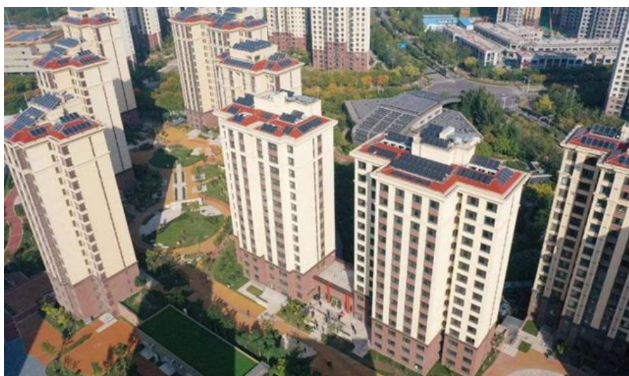
图 23 公屋二期 4、5 号楼被动房示范项目
