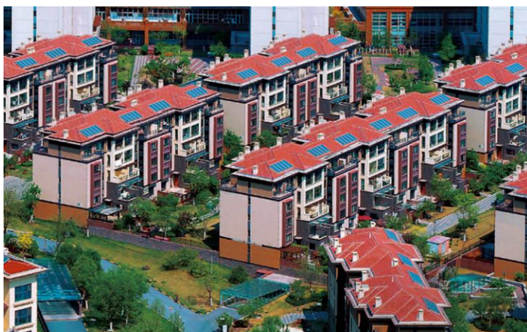
图 30 生态城居住建筑太阳能光热利用
