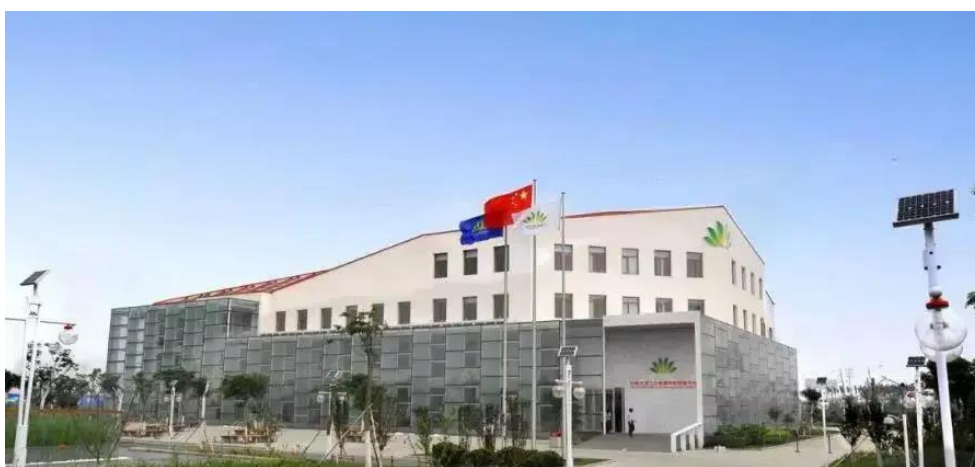
图 32 土壤热泵源技术应用项目
